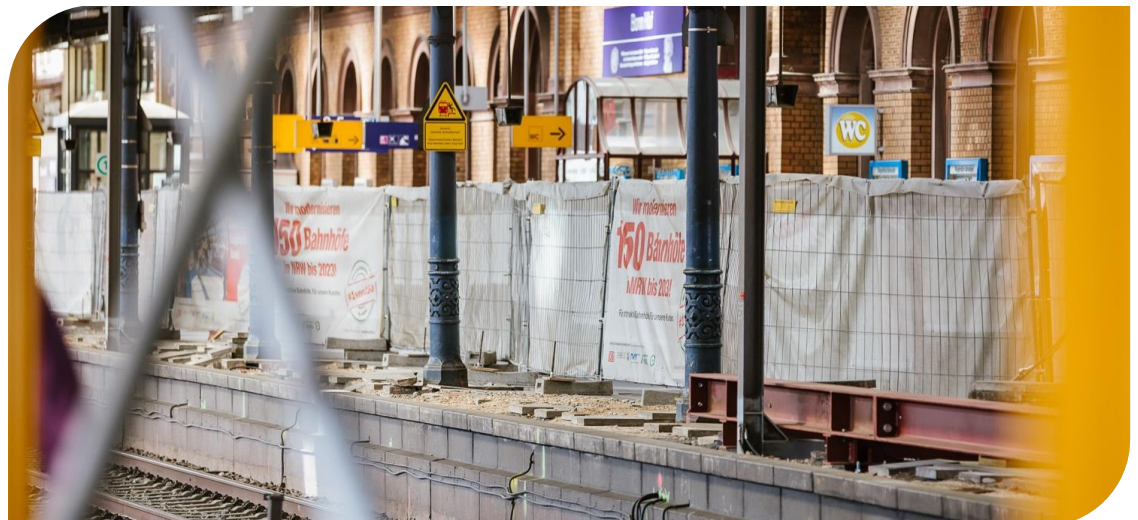
Abb. 10: Bauarbeiten an Gleis 1 in Bonn Hbf
