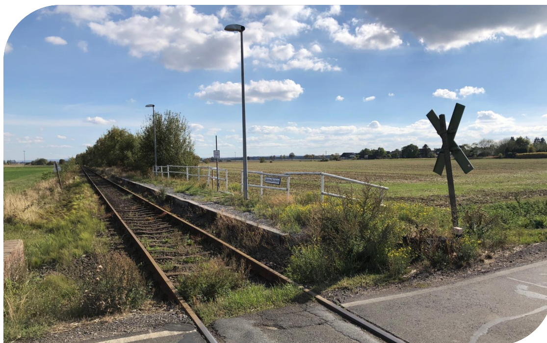
Abb. 14: Station Jakobwüllesheim entlang der Bördebahn
