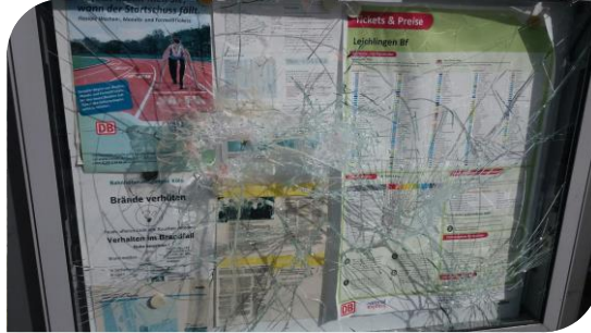
Abb. 5: Vandalismus in Leichlingen
