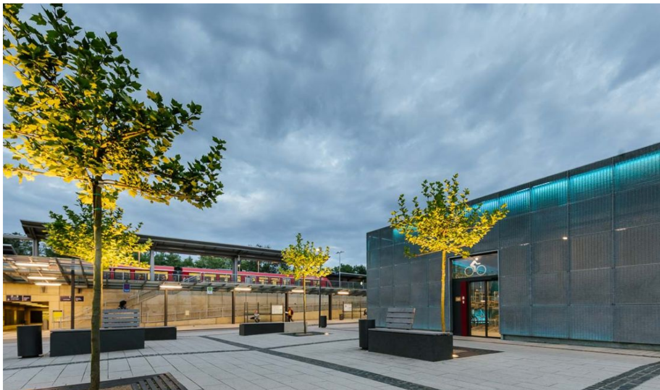
Der zur Mobilstation ausgebaute Bahnhof in Erfstadt-Liblar. (© NVR GmbH / Smilla Dankert)
