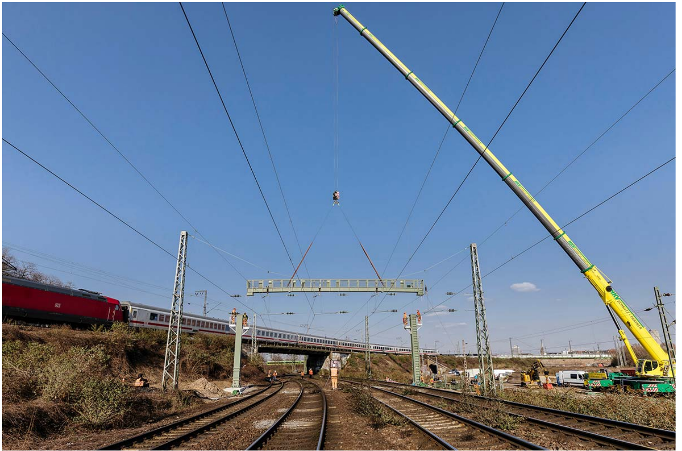
Eine neue Signalbrücke schwebt mit schwerem Gerät heran. (© NVR GmbH / Smilla Dankert)
