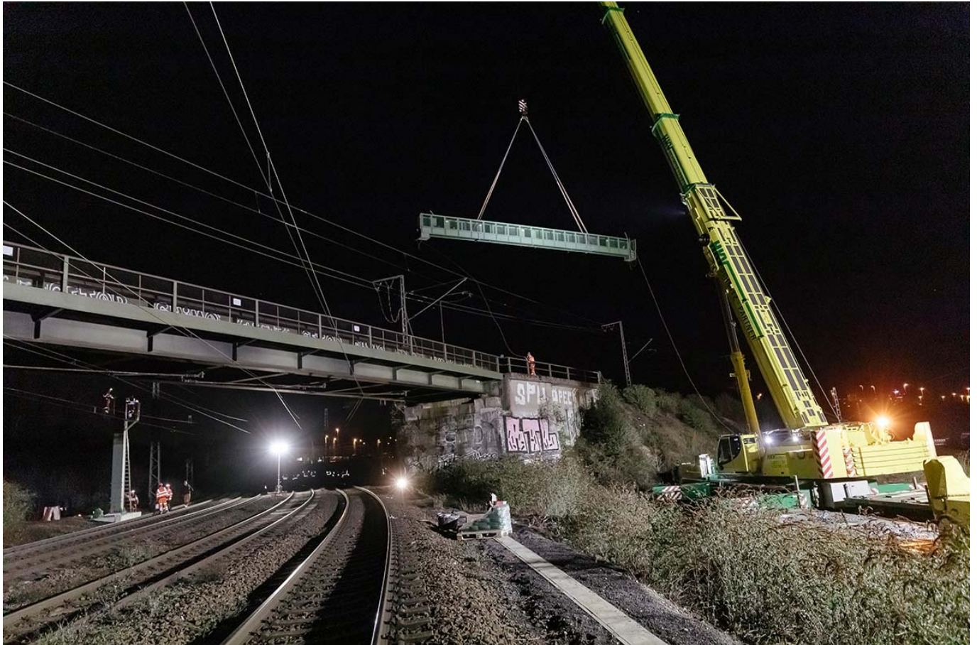
Nächtliche Bauarbeiten: Errichtung einer Signalbrücke. (© NVR GmbH / Smilla Dankert)
