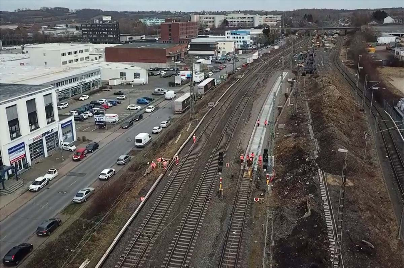
Zwischen Aachen-Rothe Erde und Eilendorf wird ein Gleis verlängert. (© Hering Bahnbau GmbH)
