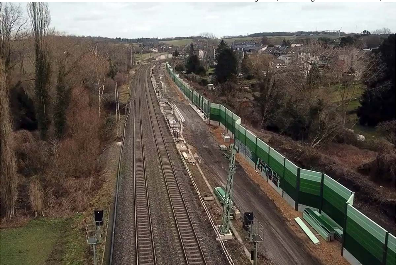
Lärmschutzwände wie hier in Eilendorf werden möglichst nah an die Gleise gebaut. (© Hering Bahnbau GmbH)
